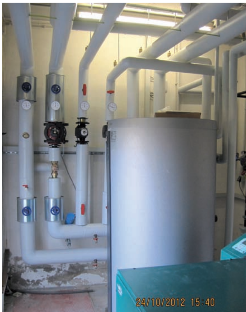
Dies ist ein Drilling: die baugleichen Anlagen mit gasbetriebenen Blockheizkraftwerken versorgen drei Gebäude mit jeweils 18 Wohnungen.
